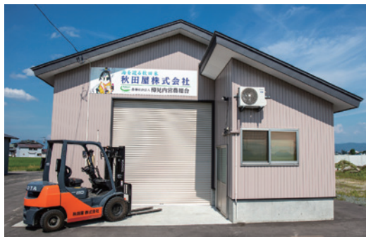
14年に輸出拡大のため秋田屋(株)設立 23年には輸出用の低温倉庫を整備
